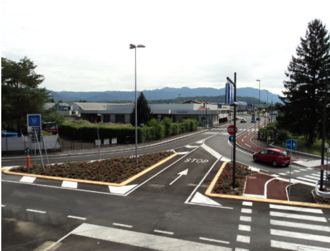
2° lotto - vista d'insieme dei lavori ultimati in via Trieste
