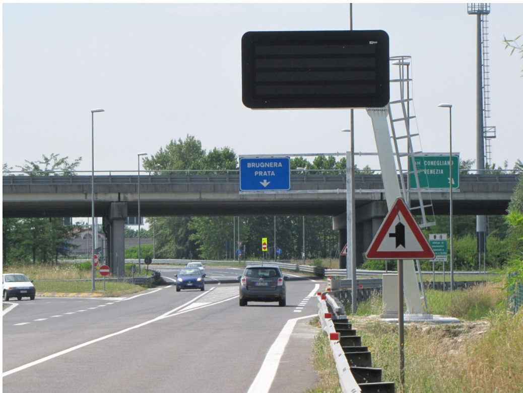
Installazione pannelli a messaggio variabile sulla A28
