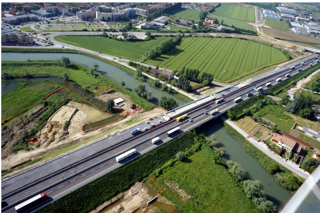
Terza Corsia – Ponte Sul fiume Piave
