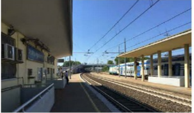
Stato di fatto -vista lato binari
